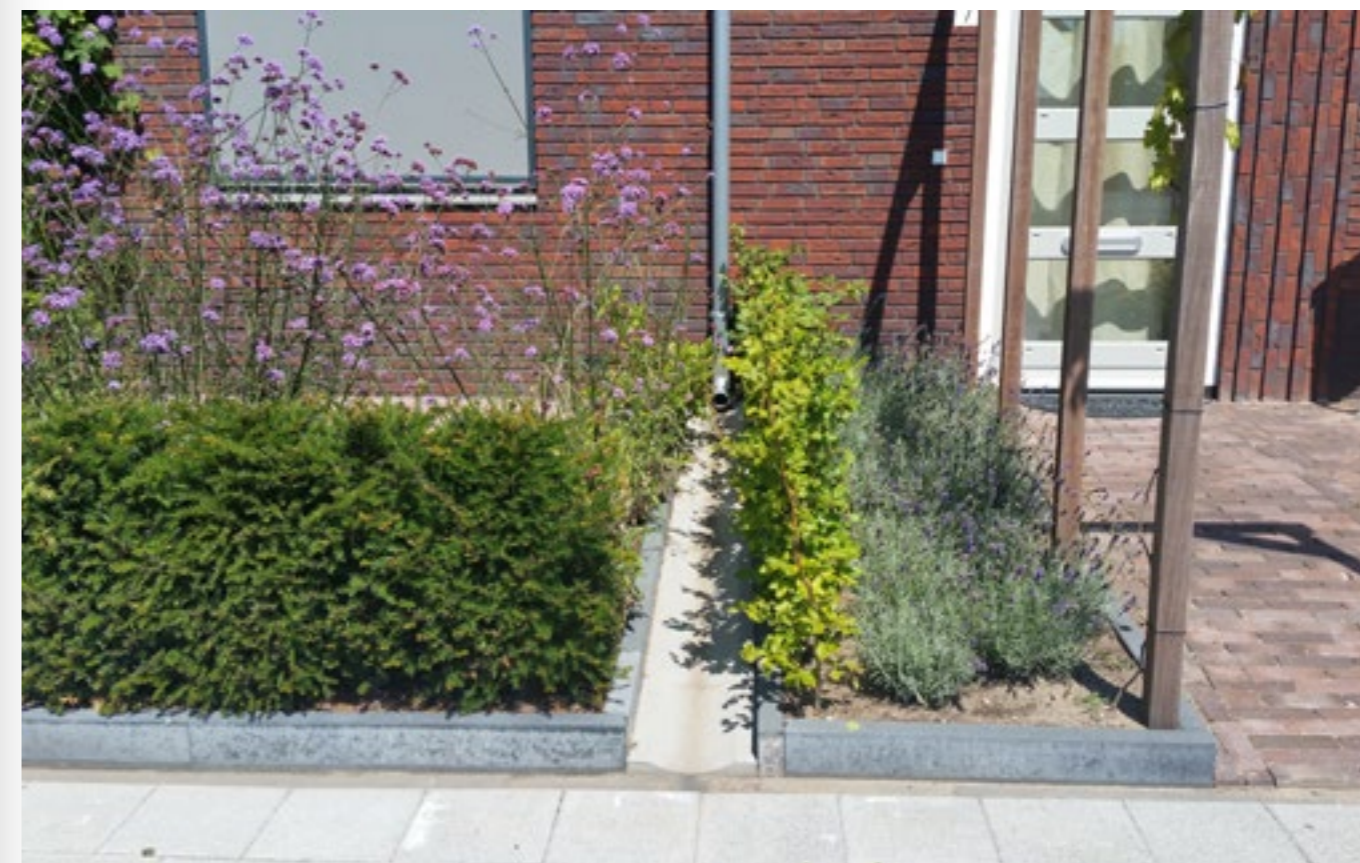
Foto afgekoppelde woning (bron: Nanda Sluijsmans)
