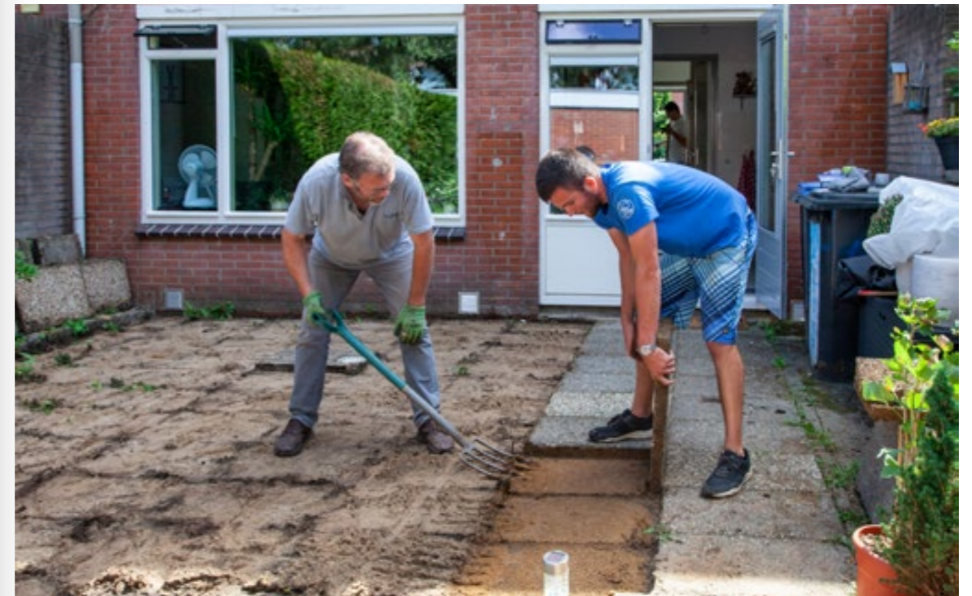
Foto ontsteden tuin (bron: Sjon Heijenga www.sjon.nl )
